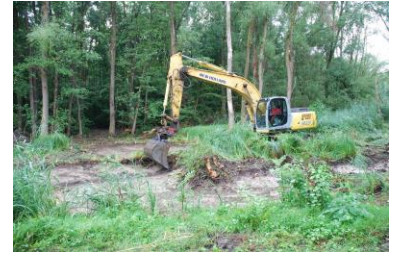
Baggerarbeiten für den Moorfrosch
